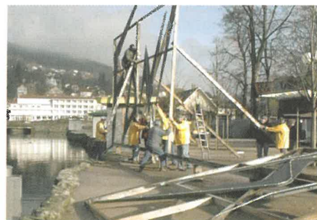
La mise en place des lettres
